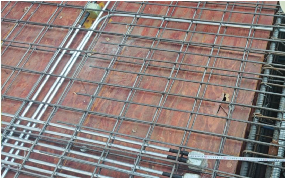
图 3.4 类似项目配管现场施工实景图
