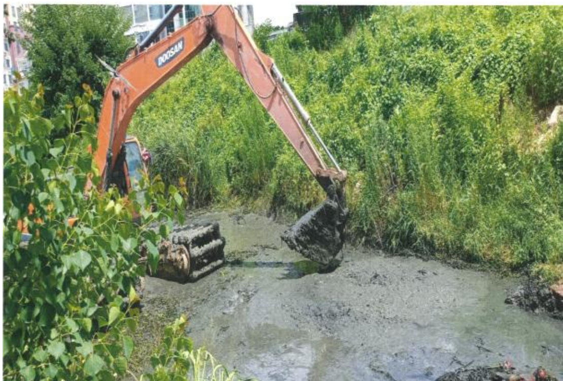
图 4.6 类似项目挖掘机挖淤泥
