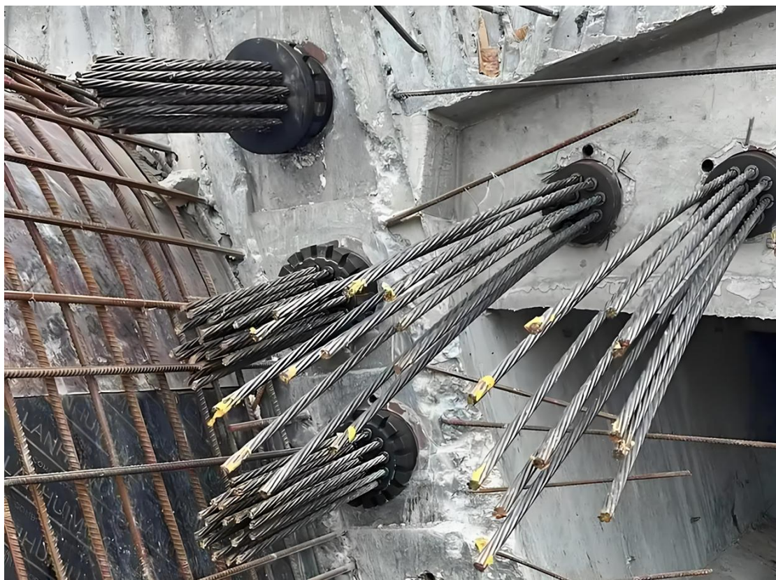
图 5.10 类似项目后张法预应力钢绞线
