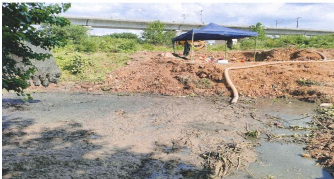
图 4.5 类似项目抽水泵排水
