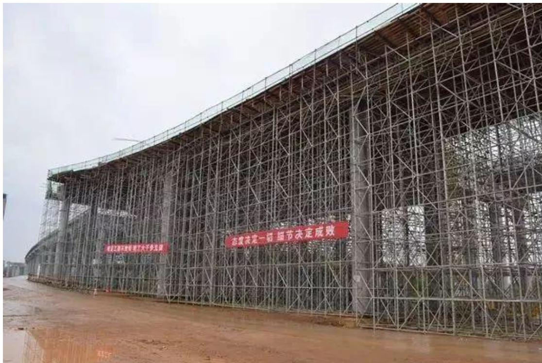
图 5.11 满堂式钢管支架
