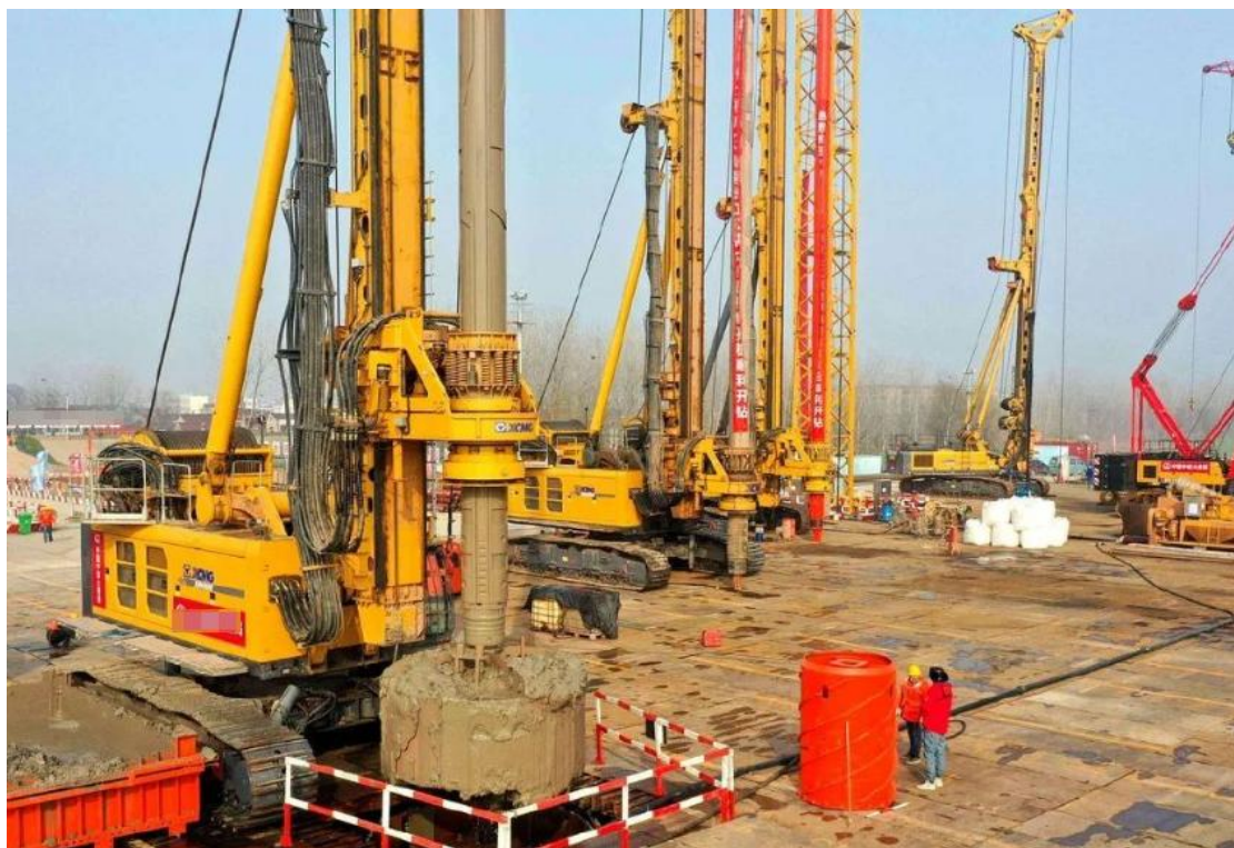
图 5.2 类似项目钻孔灌注桩
